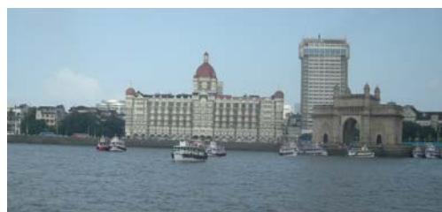
Vista desde el mar, al retornar de la Isla Elefanta al muelle de pasajeros, donde está la Puerta de Mumbai y el Hotel Taj
